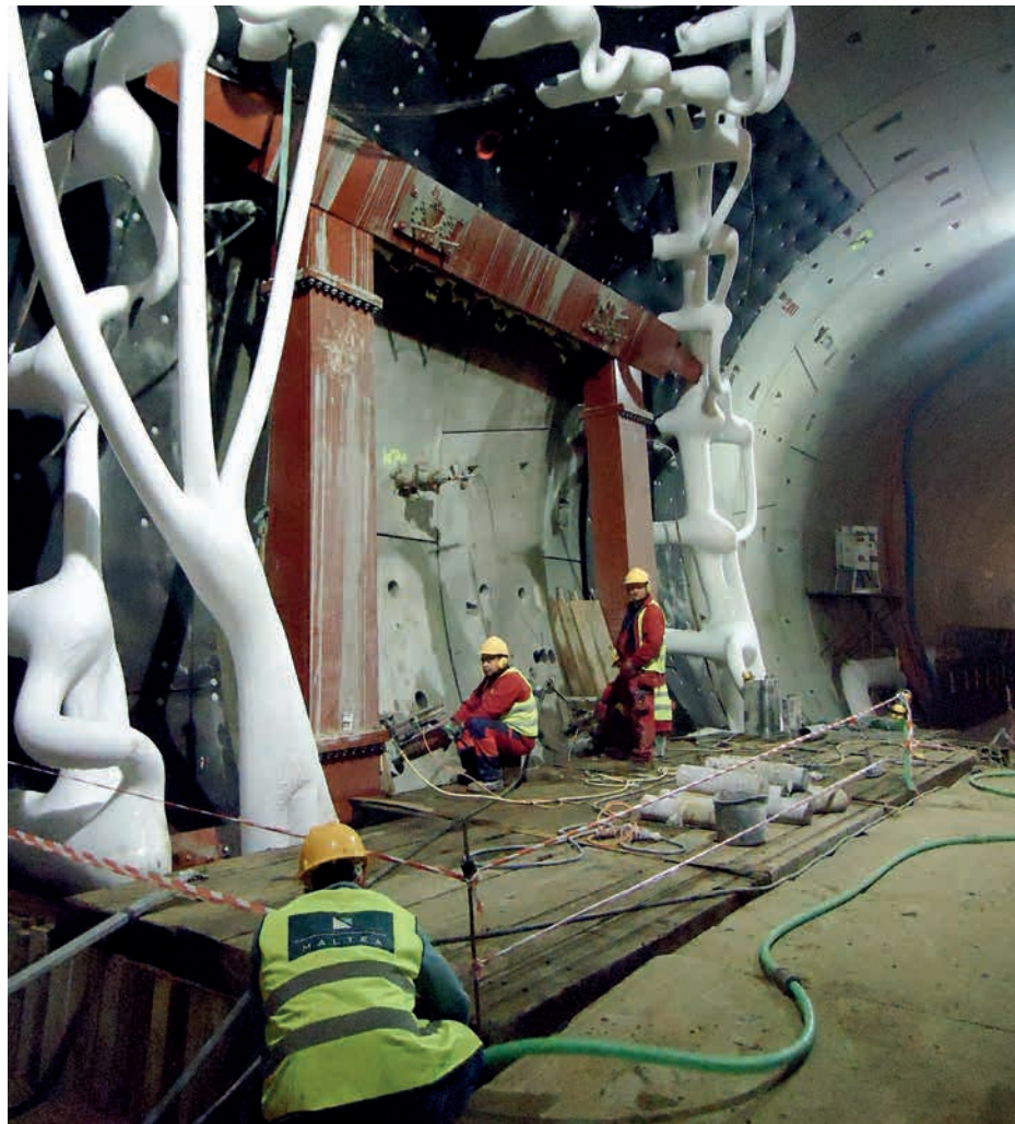
Unikátní metoda zmrazování zeminy při budování propojek mezi tubusy.
