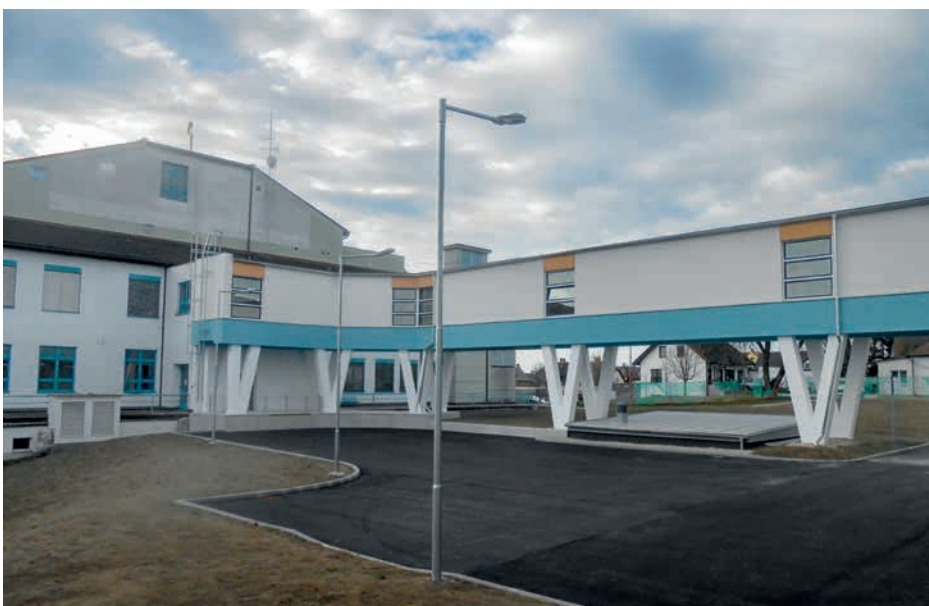
Pohled na stávající spojovací chodbu z místa staveniště
