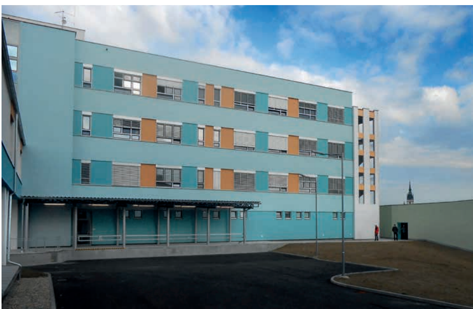
Pohled na stávající Pavilon D a prostor staveniště
